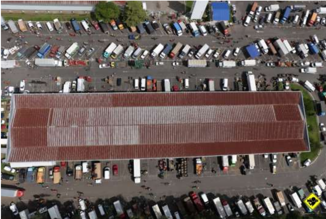
FIGURA 1 – VISTA DE CIMA DO PAVILHÃO PERMANENTE, LOCAL DA OBRA DAS COBERTURAS.
