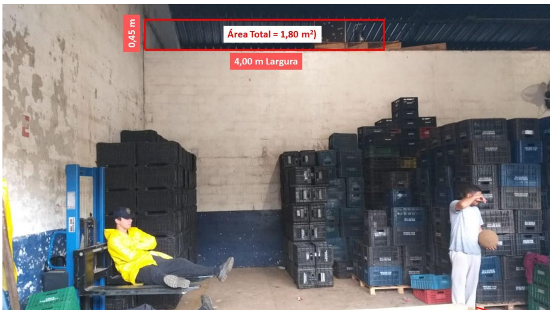
FIGURA 2 – Representação da área total (1,8 m 2 ) a ser construída (retângulo linhas vermelha) sob a parede de fundo do Box e as respectivas metragens.
