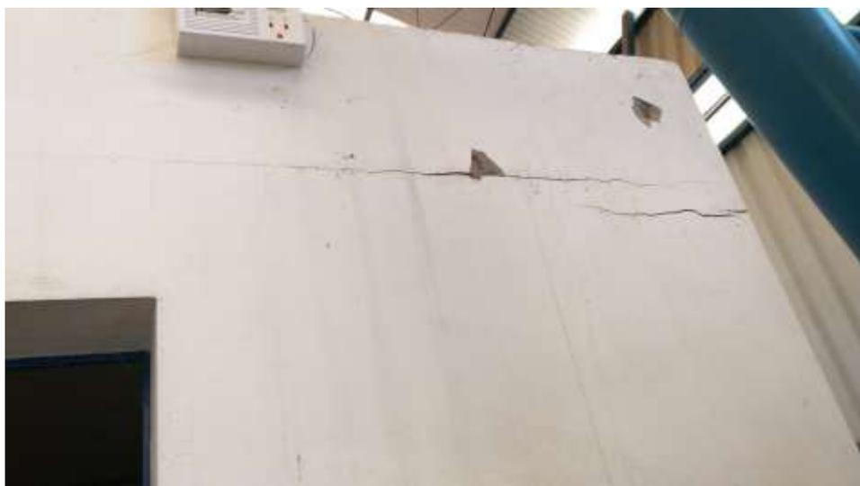
**FIGURA 5** – Rachaduras na parede face externa do sanitário masculino no Galpão Não Permanente (Pavilhão Produtor).
