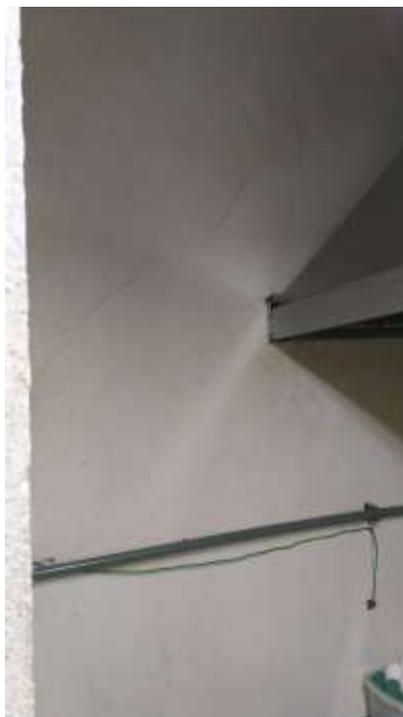
**FIGURA 1** – Rachaduras no teto (laje) da face interna da lancheria, Galpão Não Permanente (Pavilhão Produtor).
