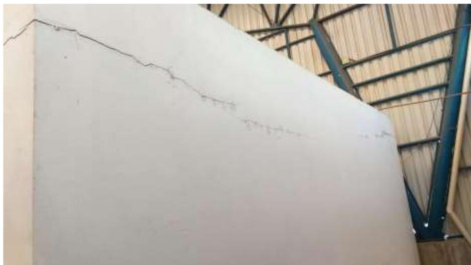
**FIGURA 6** – Rachaduras na parede da face externa sanitário masculino, Galpão Não Permanente (Pavilhão Produtor).
