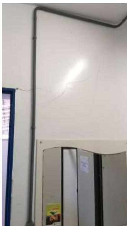
**FIGURA 4** – Rachaduras na parede da face interna do sanitário feminino, Galpão Não Permanente (Pavilhão Produtor).
