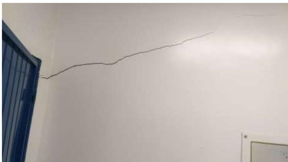
**FIGURA 8** – Rachaduras na parede da interna do sanitário masculino, Galpão Não Permanente (Pavilhão Produtor).
