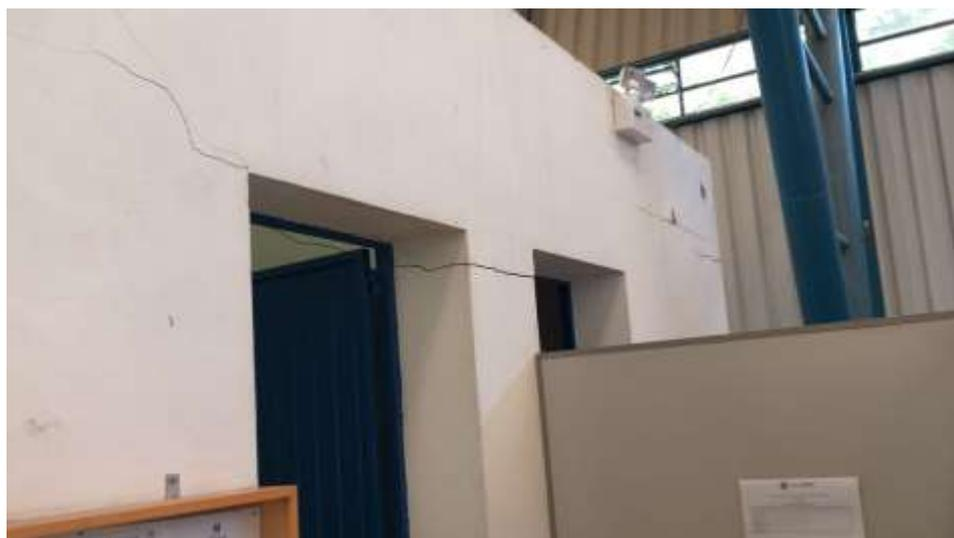
**FIGURA 2** – Rachaduras na parede da face externa dos sanitário masculino, Galpão Não Permanente (Pavilhão Produtor).
