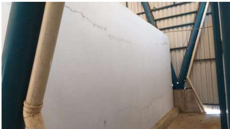
**FIGURA 7** – Rachaduras na parede da face externa do sanitário masculino, Galpão Não Permanente (Pavilhão Produtor).
